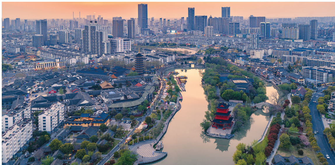
Construída em 1415 em Huai'an, a Grande Eclusa de Qingjiang é, das antigas, a mais bem preservada do Grande Canal. Juntamente com o seu vizinho, o Pavilhão Qingjiangpu, testemunha a história deste local como centro do transporte hidroviário norte-sul e da distribuição de cereais.
